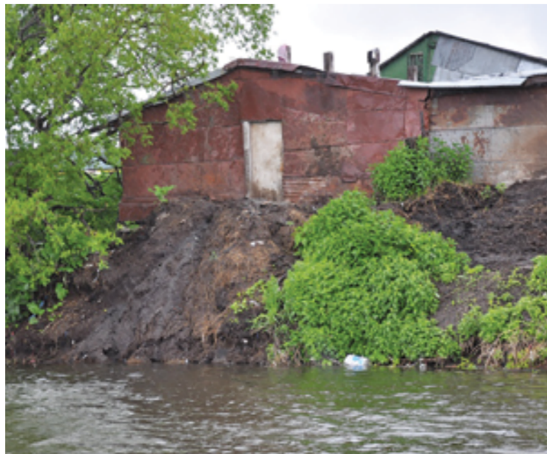
▲ Здесь не особо озадачиваются проблемами вывоза отходов
